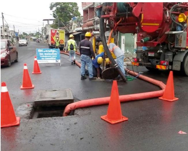
*Seit Anfang 2017 saniert die Ludwig Pfeiffer Hoch- und Tiefbau GmbH & Co. KG das Abwassernetz des La Chala-Beckens in Guayaquil, Ecuador. Im Rahmen des Projekts wurden 450 km Abwasserleitungen gereinigt. Darüber hinaus saniert das deutsche Familienunternehmen ca. 100 km des Abwassernetzes mit verschiedenen grabenlosen Technologien sowie 400 Schächte. Für das Vorhaben stellt die Bundesrepublik Deutschland eine isolierte Vertragsgarantiedeckung mit Avalgarantie zur Verfügung.*
